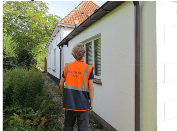
Figuur 22 Overzicht van de muren van het pand
