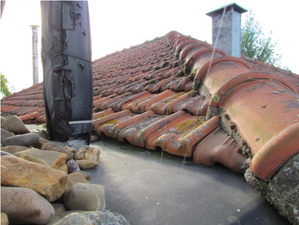
Figuur 7 Dakpannen op het platte dak
