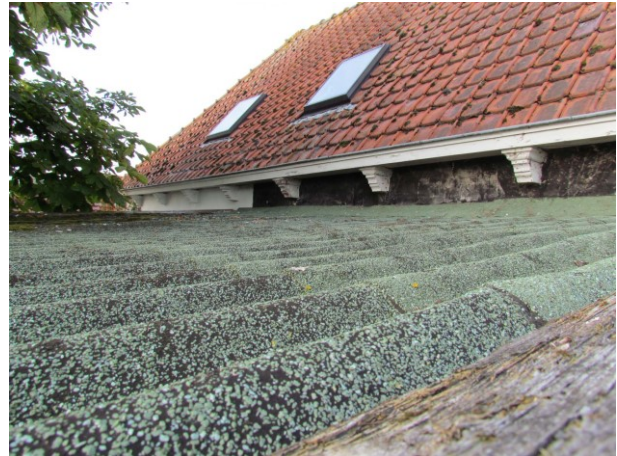
Figuur 14 Golfplaten op het dak van de uitbouw
