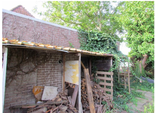
Figuur 12 Achterzijde schuur
