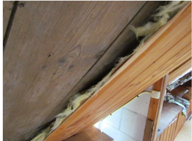
Figuur 20 Steenwol als isolatiemateriaal in de zolder
