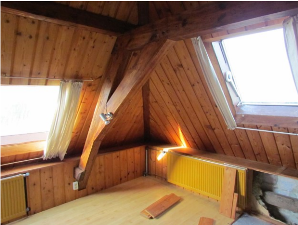
Figuur 19 Overzicht van de betimmering in de zolder
