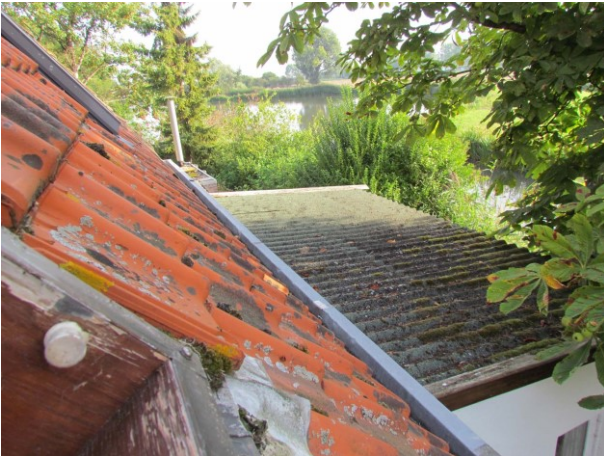
Figuur 13 Bovenaan­zicht uitbouw vanuit dakraam
