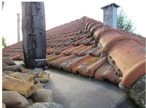
Figuur 18 Dakpannen zonder uitvlieg mogelijkheden
