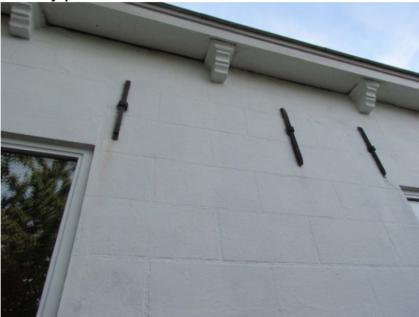
Figuur 21 Dichte muren zonder ruimte voor vleermuizen
