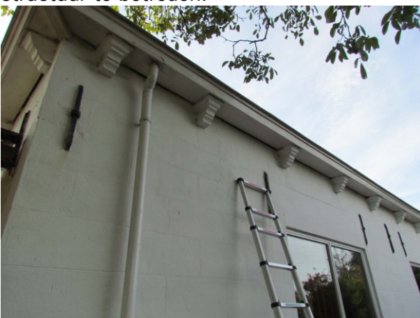
Figuur 23 Betimmering om de dakgoot
