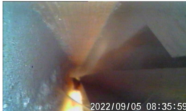
Figuur 25 Foto gemaakt met een endoscoop van de ruimte in de betimmering om de dakgoot
