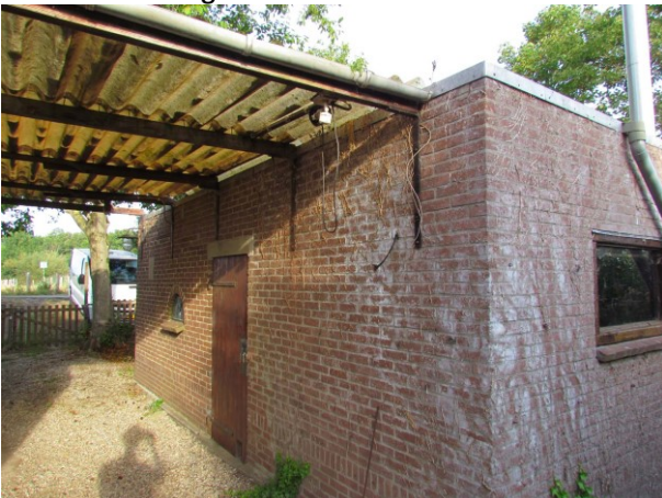
Figuur 11 Voorzijde schuur met overkapping
