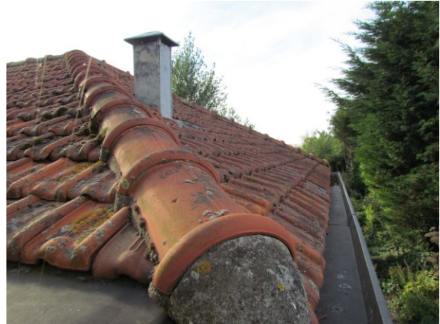
Figuur 8 Dakpannen boven de dakgoot
