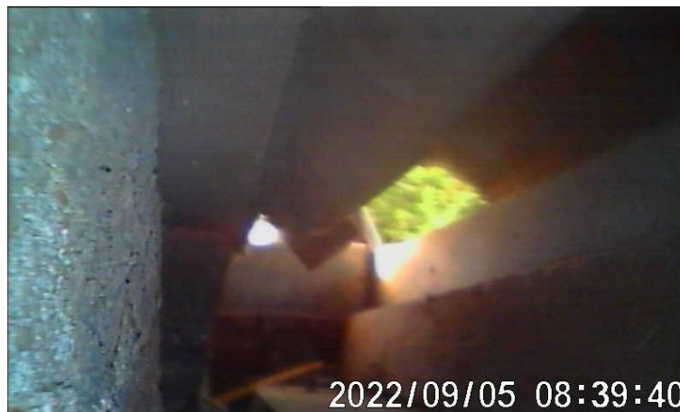
Figuur 27 Foto gemaakt met een endoscoop van de opening in de hoek van de betimmering om de dakgoot
