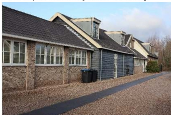
De te slopen bebouwing achter de woning.
