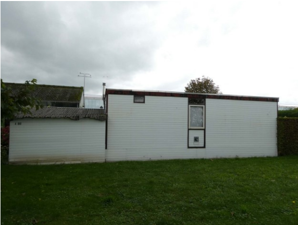
Figuur 4 Overzicht voorzijde bijgebouw
