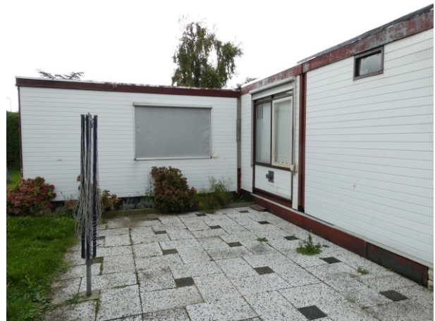
Figuur 5 Overzicht achterzijde bijgebouw
