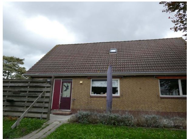
Figuur 3 Overzicht achterzijde woning
