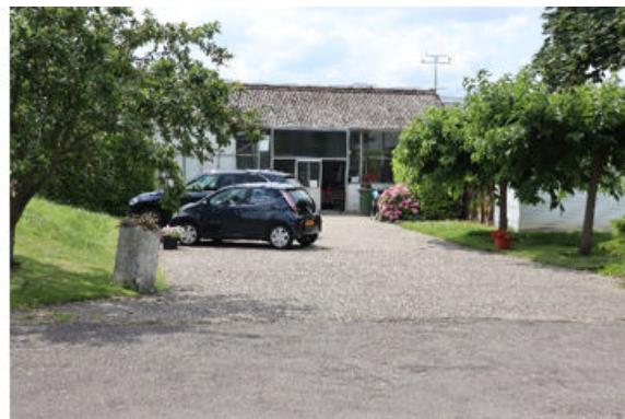
Bestaande inrit van het agrarisch bedrijfsperceel.
