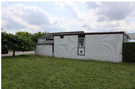
Het bestaande kantoor (voormalige noodwoning).
