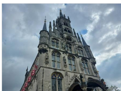
Figuur 2.4 Zuidgevel van het stadhuis.
