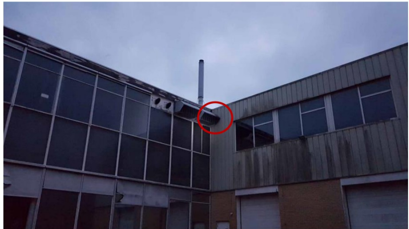
Figuur 5: Ingang aangetroffen zomerverblijf Gewone dwergvleermuis
