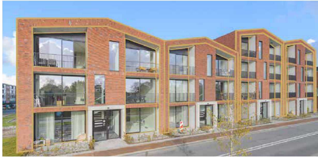
Appartementen gebouw van samengestelde bouwvolumes Bouwvolume accentueren met (gemetseld) kader Gelaagdheid in gevel door terugliggend gevelvlak
