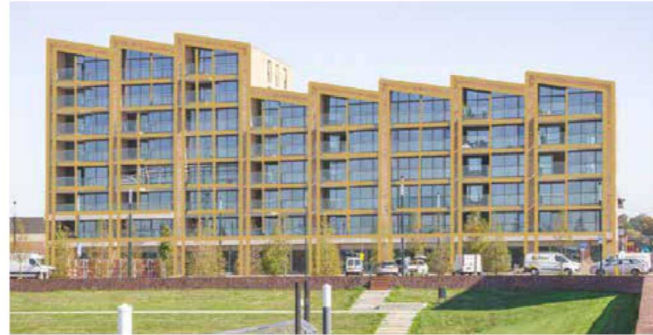
Appartementen gebouw van samengestelde bouwvolumes Bouwvolume accentueren met (gemetseld) kader Gevel met horizontale en verticale belijning
