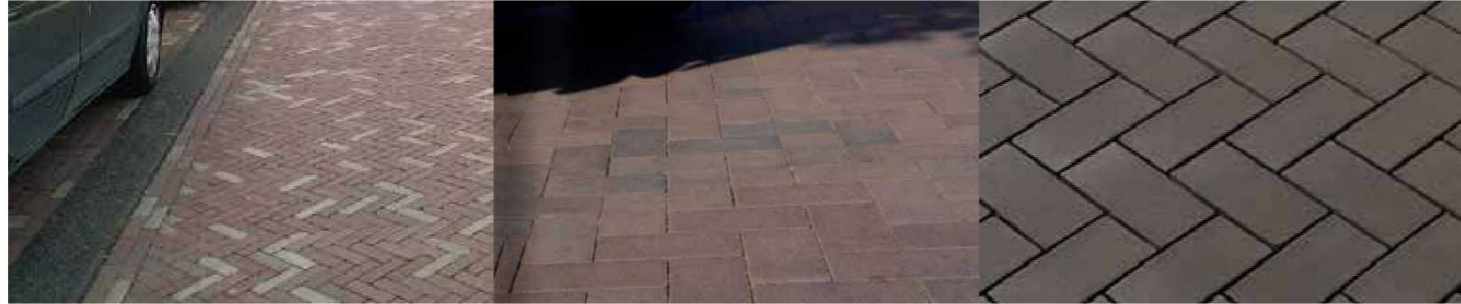
gebakken klinkers rijloper Oud Bodegraafseweg en aansluitende bruin-mangaan-grijze straatstenen voor woonstraten en parkeercoffers
