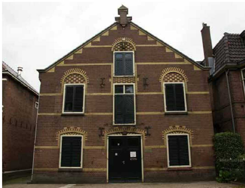
Kaaspakhuis, Burgemeester Le Coultrestraat 3, Bodegraven
