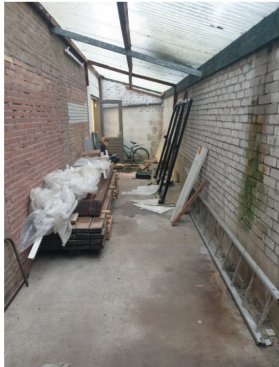
Foto 2: tussenuimte naast Voorplein 3.
