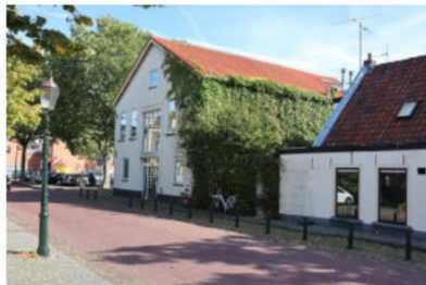
Bebouwing aan Pastorieplein 1.
