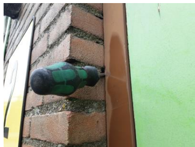
Geen asbestverdacht materiaal aangetroffen : Spouwmuur
