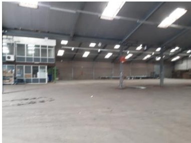
Algemeen : Binnenzijde loods 1 en 2
