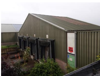
Geen asbestverdacht materiaal aangetroffen : Buitenzijde dockshelter
