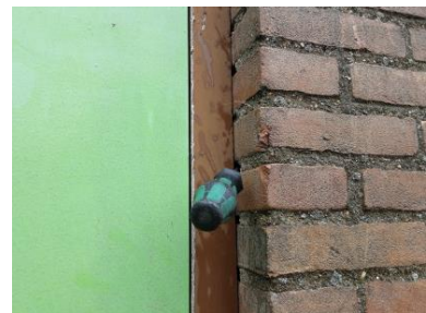
Geen asbestverdacht materiaal aangetroffen : Spouwmuur
