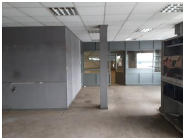
Geen asbestverdacht materiaal aangetroffen : Kantoor loods 1997
