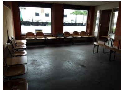
Geen asbestverdacht materiaal aangetroffen : Vloer in kantoor
