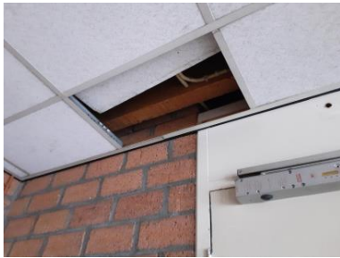
Geen asbestverdacht materiaal aangetroffen : Ruimte boven plafonds
