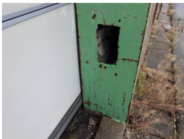
Geen asbestverdacht materiaal aangetroffen : Binnenzijde spouwmuur
