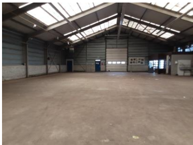
Geen asbestverdacht materiaal aangetroffen : Loods 1997
