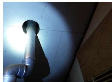
Niet asbestverdacht : Beplating in cv-ruimte
