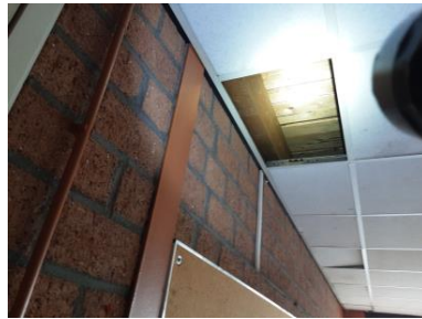
Geen asbestverdacht materiaal aangetroffen : Ruimte boven plafonds
