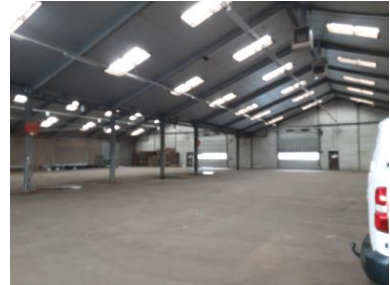
Algemeen : Binnenzijde loods 1 en 2
