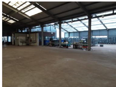
Geen asbestverdacht materiaal aangetroffen : Loods 1997
