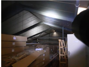
Algemeen : Binnenzijde dak
