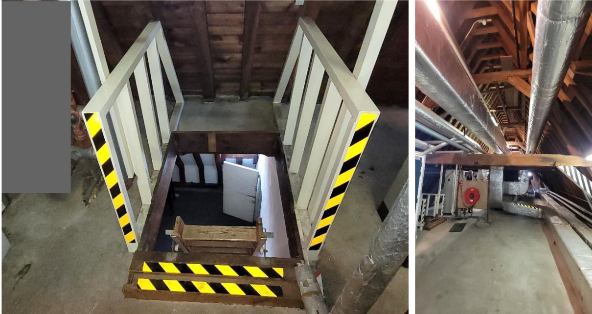
Linker afbeelding: de bij de restauratie aangebrachte vlizotrap die uitkomt in de leeszaal (4.03).
