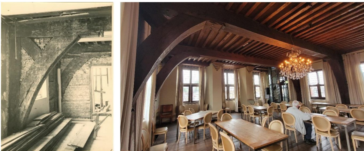
Linker afbeelding: muurstijl met peerkraalsleutelstuk, moerbalk en korbeel in het zuidoostelijke deel van de voormalige bodewoning. (Herkomst: Streekarchief Midden-Holland, beeldbank inv.nr. 0440.72852)
