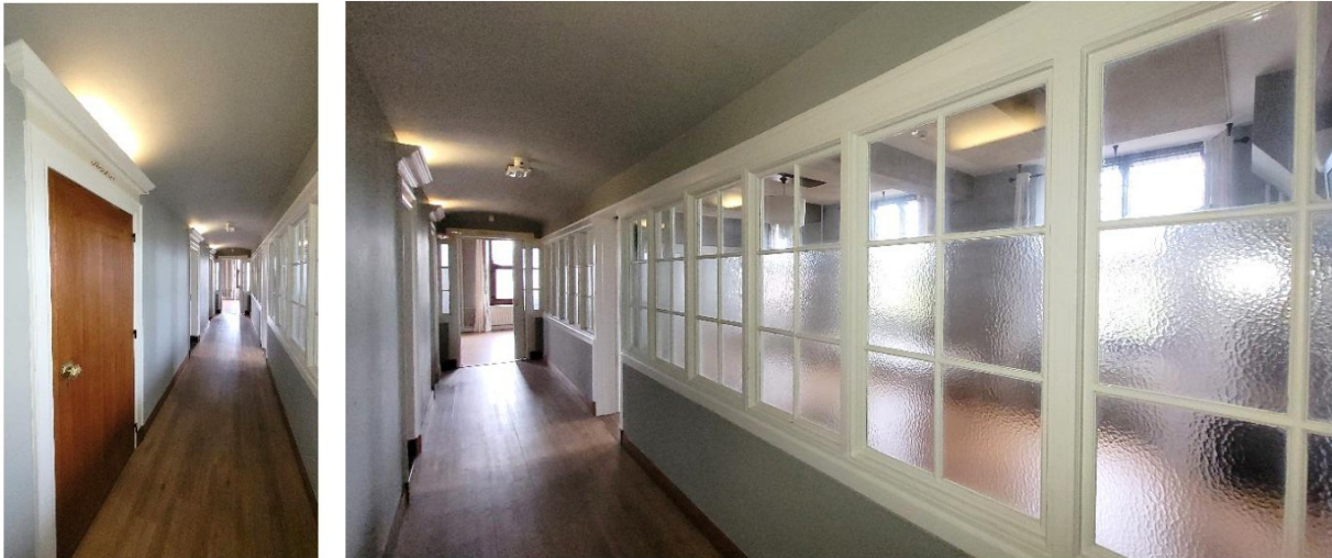
De gang met huidige moderne vloerafwerking en verglaasde wand uit 1947-1952). Gezien richting het noorden.
