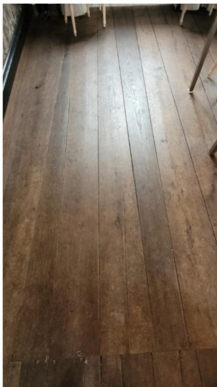
Detail kop-staart gelegde vloerdelen.
