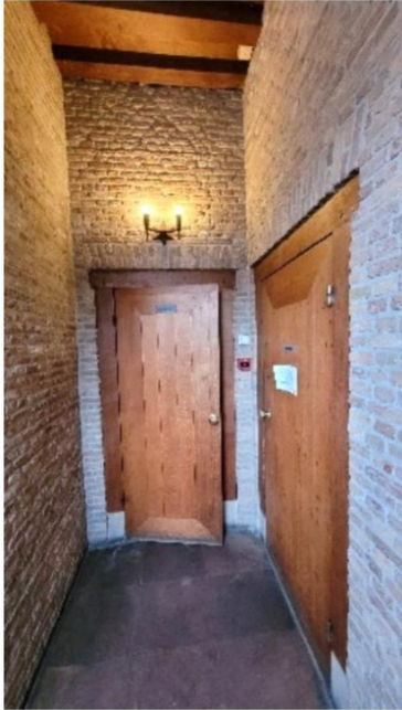
Portaal met metselwerk in het zicht. De plavuizenvloer, houten balkenplafond, werkkast en trap naar de onderverdieping dateren uit 1947-1952.
