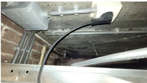
Linker afbeelding: ruimte 1.03. De betonvloer met plankenstructuur achter het verlaagd plafond.
