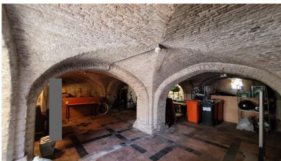
Fietsenkelder met muren uit Gobertanger steen en ribloze gewelven van baksteen.
