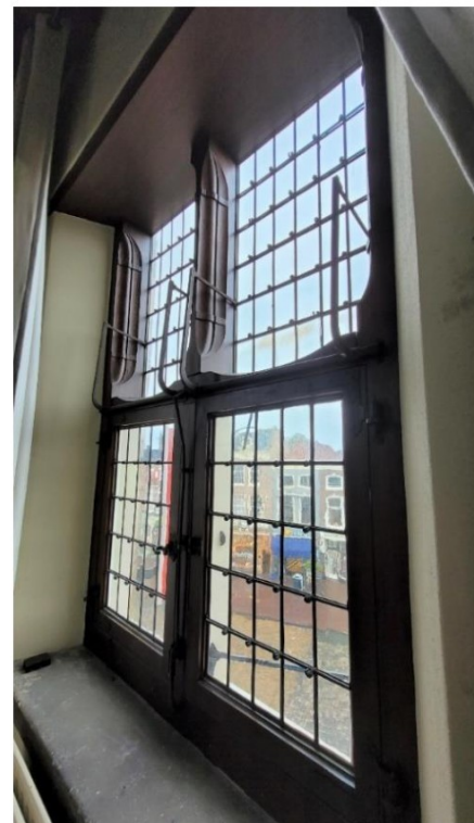
Gotiserend houten kruiskozijn met klepraam in het bovenlicht.
