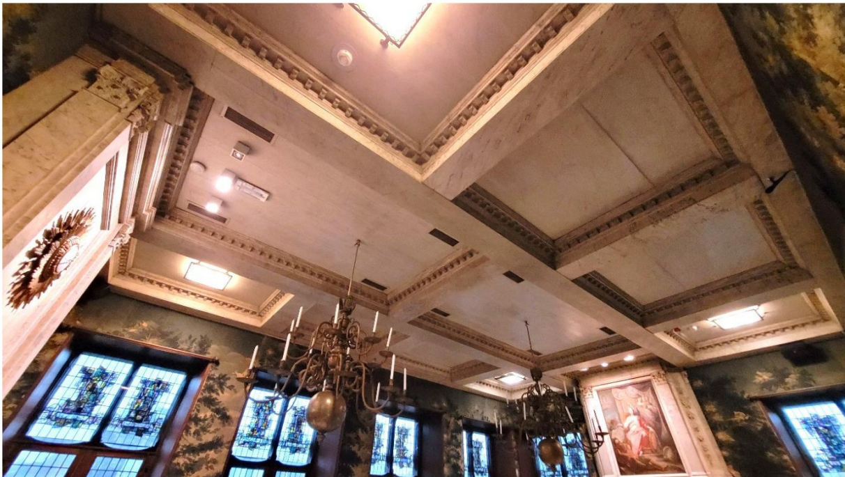
Cassettenplafond in de trouwzaal.
