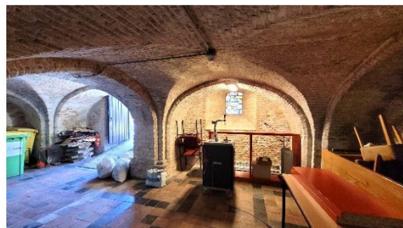
Fietsenkelder met muren uit Gobertanger steen en ribloze gewelven van baksteen.
