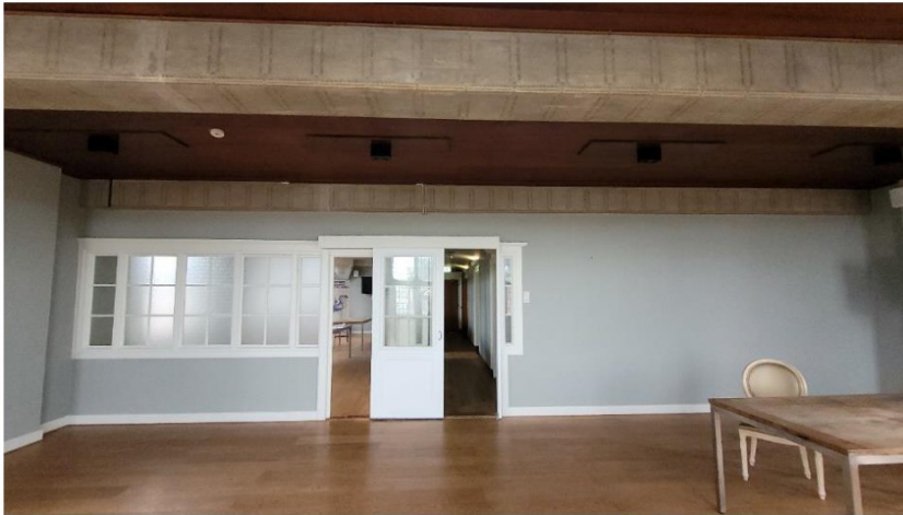
Betonbalken voorzien van een beschilderde decoratie in ruimte 3.07.
