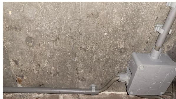
Linker afbeelding: ruimte 1.03. De betonvloer met plankenstructuur achter het verlaagd plafond.
