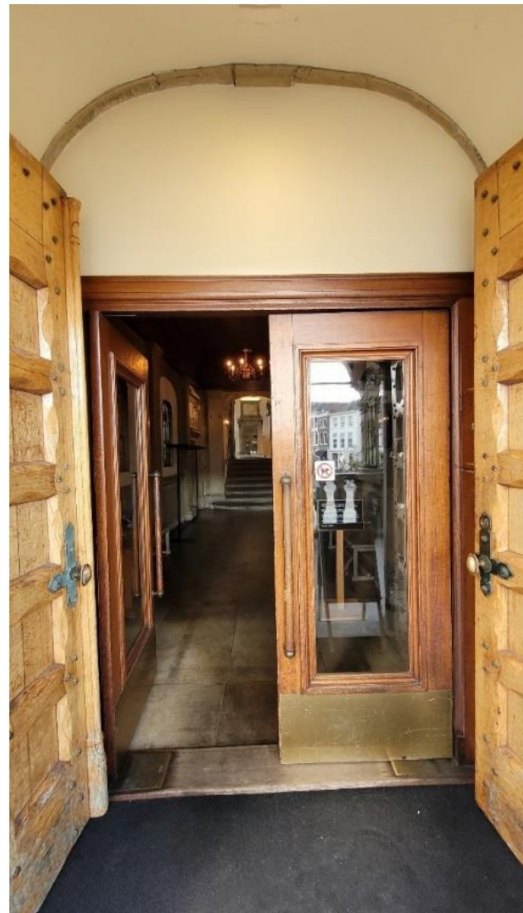
Het tochtportaal gezien vanaf de entree met gotische deuren.
