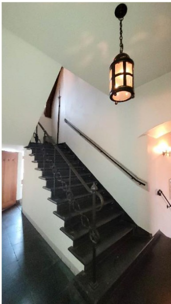
Linker afbeelding: betonnen trap met hardstenen treden, siersmeedijzeren leuning met sterren en doornen, in een 'goot' van marmer gemonteerde trapleuning en smeedijzeren plafondlamp.
