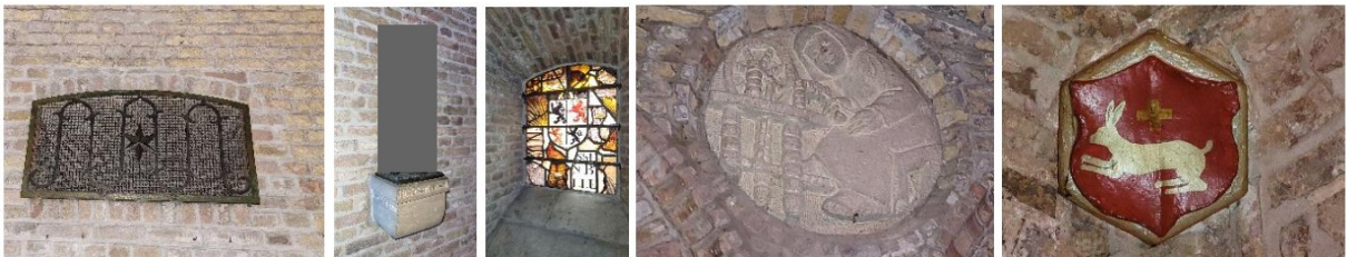
Interieurelementen uit de tijd van de restauratie (1947-1952) van links naar rechts: ventilatierooster met het symbool van een zespuntige ster met doornen, bronzen beeldje van ██████████, raam met gebrandschilderd glas van hergebruikte scherven, natuurstenen medaillon met het beroep van spinster en één van de aangebrachte wapens van stadsbestuurders als sluitsteen, in dit geval ██████████ schepen in 1450.
