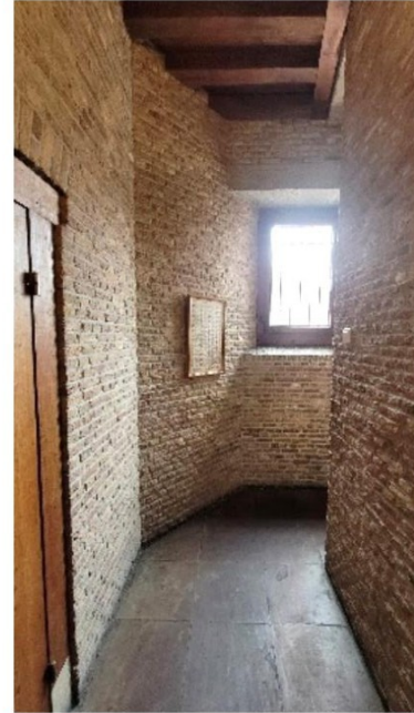
Portaal met metselwerk in het zicht. De plavuizenvloer, houten balkenplafond, werkkast en trap naar de onderverdieping dateren uit 1947-1952.
