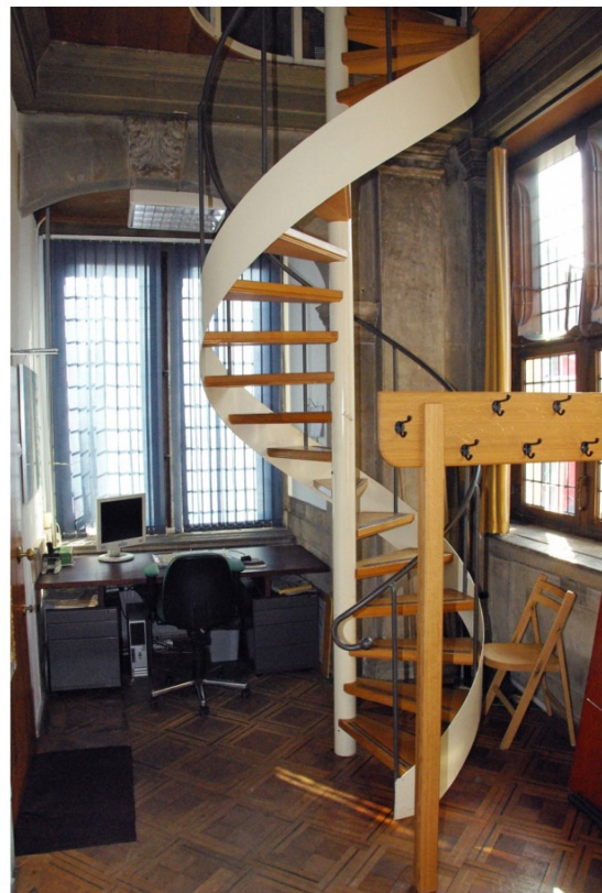
Afb. 52 De kamer van de marktmeester (2.02), voorheen wethouderskamer, met daarin de in 1996 aangebrachte noodtrap.
