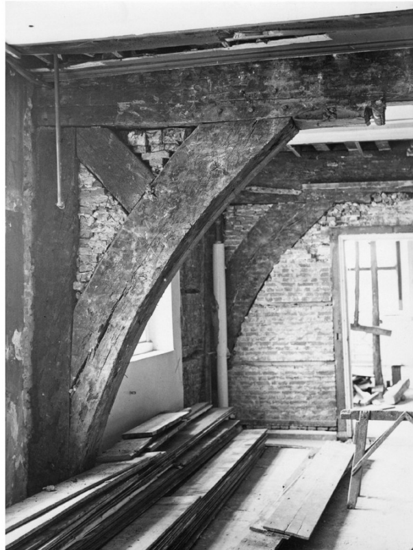
Afb. 11 Muurstijl met console en korbeel in het zuidoostelijke deel van de voormalige bodewoning (3.01). (Herkomst: Groene Hart Archieven Gouda, beeldbank inv.nr. 72852)
