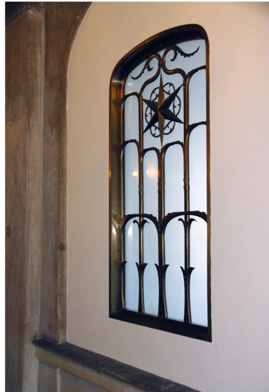
Afb. 51 Raamharnas (hekwerk) in een van de vensters in de zijwanden van het benedenplein (2.01).
