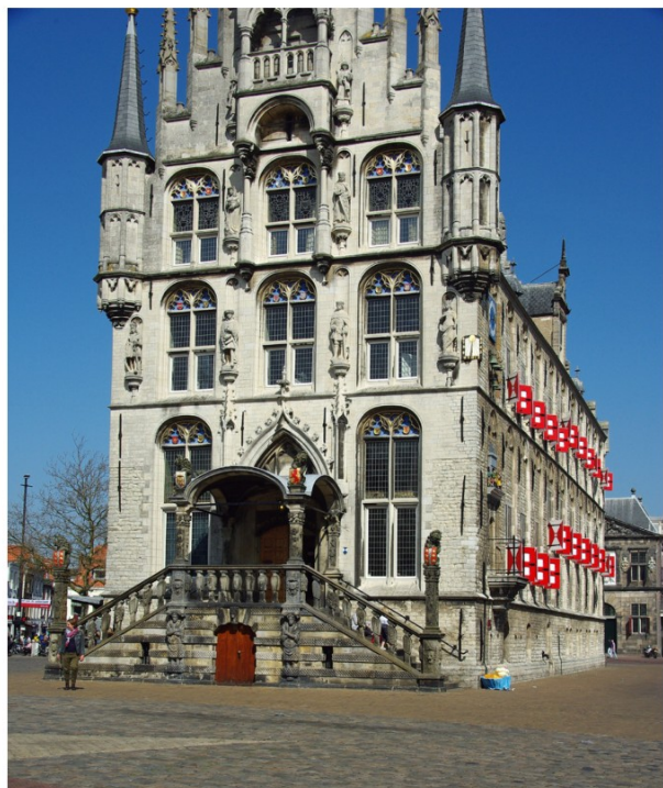
Afb. 28 Zuid- en oostgevel met aan de zuidzijde het bordes uit 1603 met de overhuiving uit 1697.
