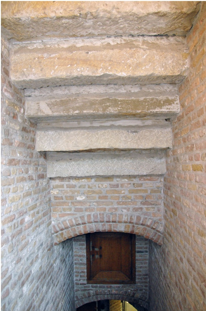
Afb. 55 Portaal (2.04) met trap naar de onderverdieping.
