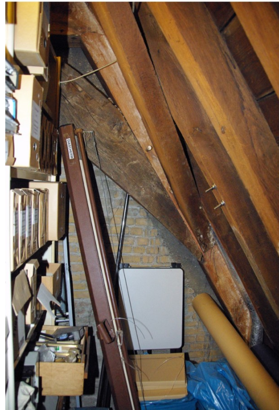
Afb. 110 Zijruimte aan de westzijde van de voormalige archiefruimte (4.04).
