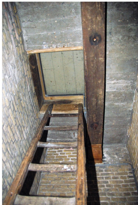
Afb. 115 Ladder in geveltoren met luik naar de klokverdieping met de bij de restauratie geconstrueerde betonnen vloer.
