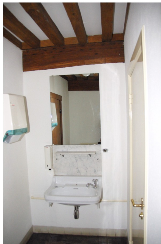
Afb. 113 Portaal van het herentoilet (4.06) met wasbak, marmeren spatscherm en planchet uit de restauratietijd.
