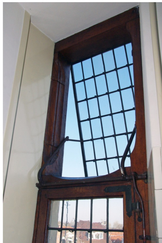
Afb. 94 Detail van tijdens de restauratie geplaatst kozijn met klepraam in het bovenlicht.
