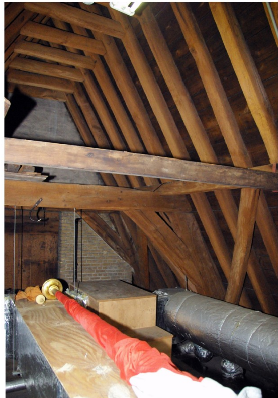
Afb. 114 Kap in het zuidelijke deel (boven de raadzaal) op de zolder op het derde juk. De daksporen zijn gekoppeld met haanhouten. Links de waarschijnlijk nog oorspronkelijke deur naar de geveltoren.
