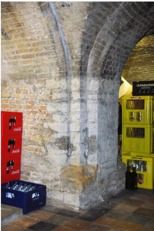
Afb. 37 Kolomvoet in de fietsenkelder (1.02) met gotisch profiel in basement.
