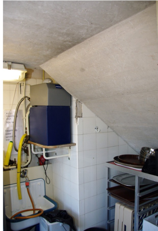
Afb. 83 Werkkast (3.10) onder de trap naar de kapverdieping. Hier komt het bij de restauratie toegepaste beton aan het licht.
