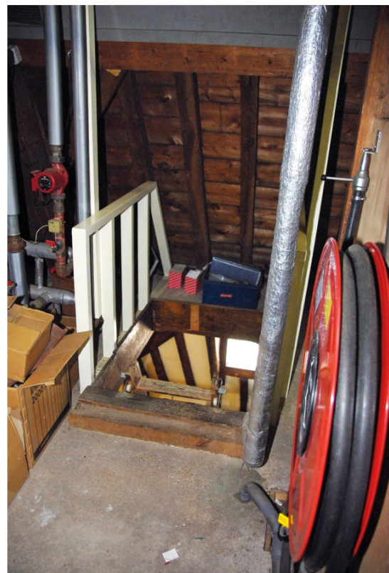
Afb. 119 De bij de restauratie aangebrachte vlizotrap die uitkomt in de leeskamer (4.03).
