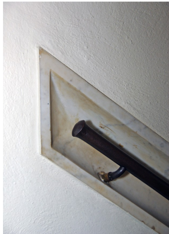
Afb. 97 Detail van de trapleuning, gemonteerd in een 'goot' van marmer. Voorbeeld van een voor het werk van Van der Steur kenmerkend zorgvuldig detail.
