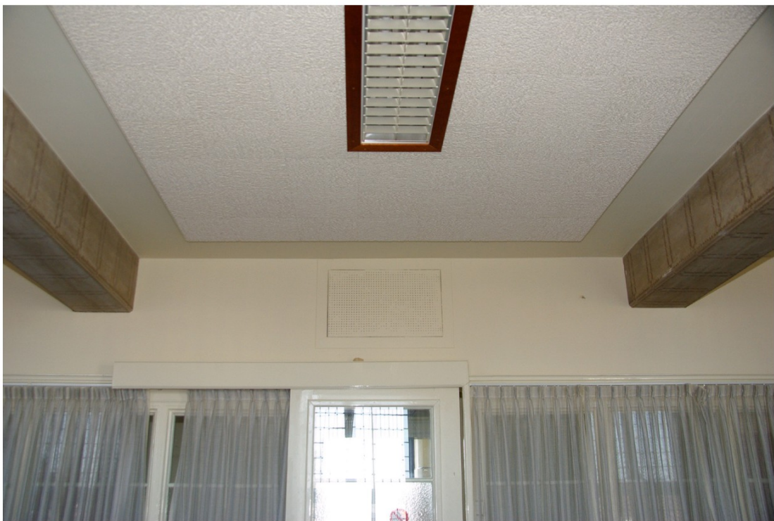
Afb. 90 Detail van het plafond in de St. Janszaal met de betonbalken die van een beschilderde decoratie zijn voorzien en een middenvlak met akoestische tegels; boven de deur een dichtgezette ventilatieopening.
