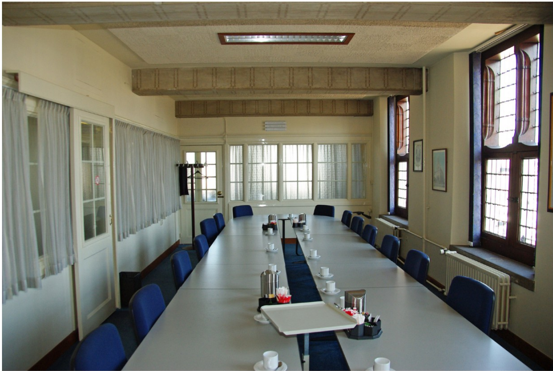
Afb. 89 De St. Janszaal, na de restauratie de ruimte van de typisten, gezien naar het noorden. Ook hier met een in schuifdeur gewijzigde deur.
