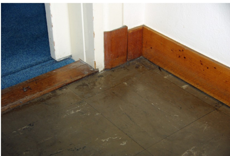
Afb. 92 Detail van de colovinyl-tegels op de vloer (3.09); een typische vloerbedekking uit de tijd van de restauratie.
