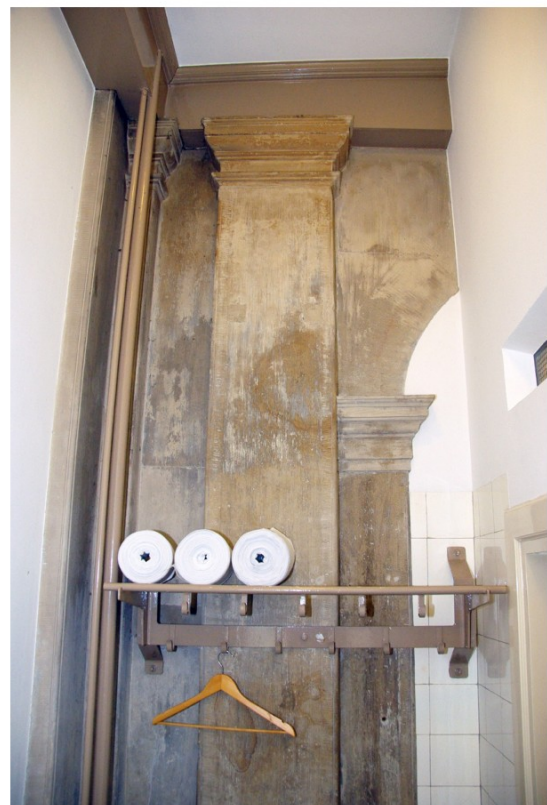
Afb. 54 Noordwand van de garderobe (2.03) met de zandstenen pilasterindeling die hoort bij het grotere benedenplein van vóór de Franse tijd.
