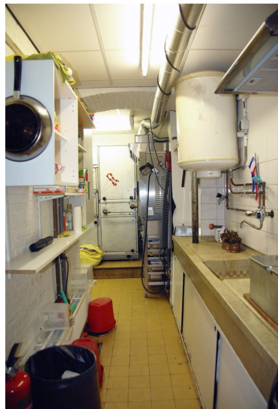
Afb. 39 Keuken (1.03) naar het oosten, met achterin de gemoderniseerde verwarmingsinstallatie en rechts een karakteristiek aanrecht uit de tijd van de restauratie.
