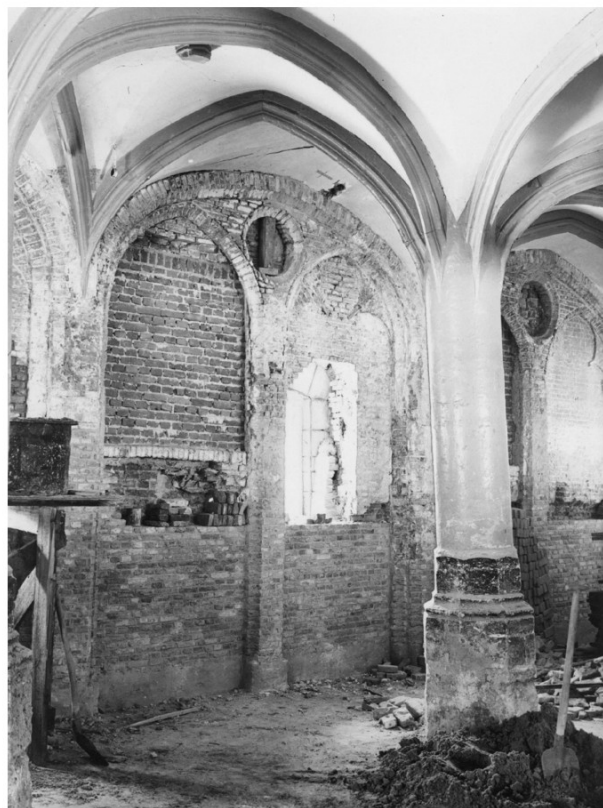
Afb. 12 Burgerhal in restauratie waarbij de wanden al ontleisterd zijn en de gewelven nog niet. In de wand zijn de gemetselde ogen zichtbaar waarin later de medaillons met kenmerkende Goudse beroepen zijn gemonteerd. (Herkomst: Groene Hart Archieven Gouda, beeldbank inv.nr. 72875)
