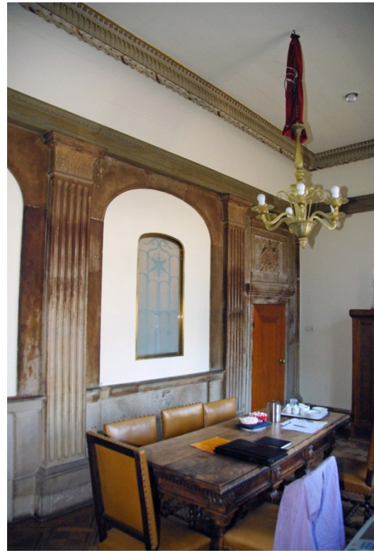
Afb. 74 De leeskamer (2.11) gezien naar het noordwesten met zandstenen pilasterstelling.
