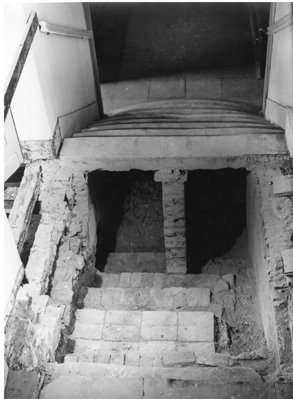
Afb. 9 Stenen trap op de bel-etage tussen voor- en achterhuis gezien vanaf het bovenplein, met links de deur naar de voormalige bodekamer (2.09-2.10). (Herkomst: Groene Hart Archieven Gouda, beeldbank inv.nr. 72851)
