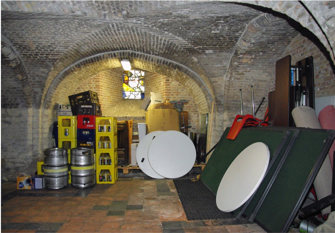
Afb. 36 De fietsenkelder (1.02) naar het westen muren uit Gobertanger steen en de gewelven van baksteen.
