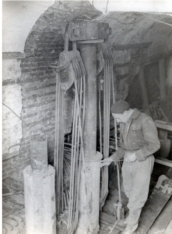
Afb. 8 Het persen van de 'de Waal'-palen in de onderverdieping. (Herkomst: Groene Hart Archieven Gouda, beeldbank inv.nr. 72915)
