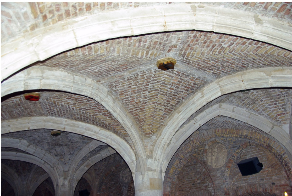
Afb. 41 Deel gewelf burgerhal (1.05) met ribben van natuursteen en velden van baksteen.
