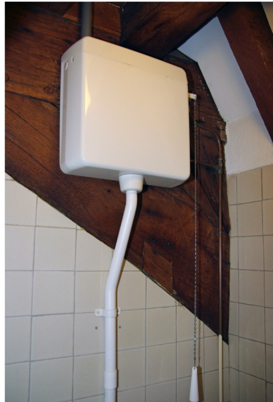
Afb. 112 De stortbak van het damestoilet (4.05) is bevestigd tegen een spant van de kapconstructie waarop het telmerk nog zichtbaar is.
