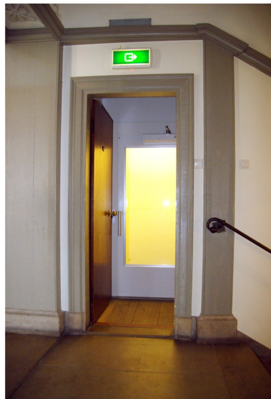
Afb. 73 Gezicht vanaf het bordes (2.08) naar de lift in ruimte (2.09), voorheen gebruikt als bodekamer.
