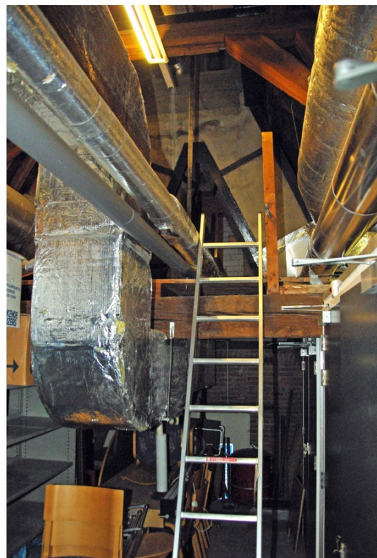
Afb. 117 Met een ladder kan de zolder boven de raadzaal bereikt worden. Op de achtergrond de schoorsteenconstructie (afb. 116).
