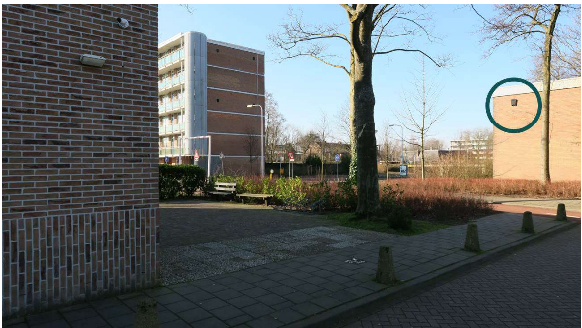
Figuur 3.2 De paarverblijfplaats van de gewone dwergvleermuis bevindt zich in een gevelkast.
