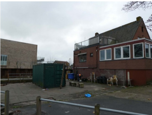
Figuur 4 Oostelijk overzicht plangebied
