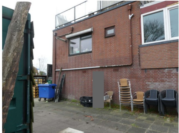
Figuur 12 Oostelijke muur met ventilatiegaten
