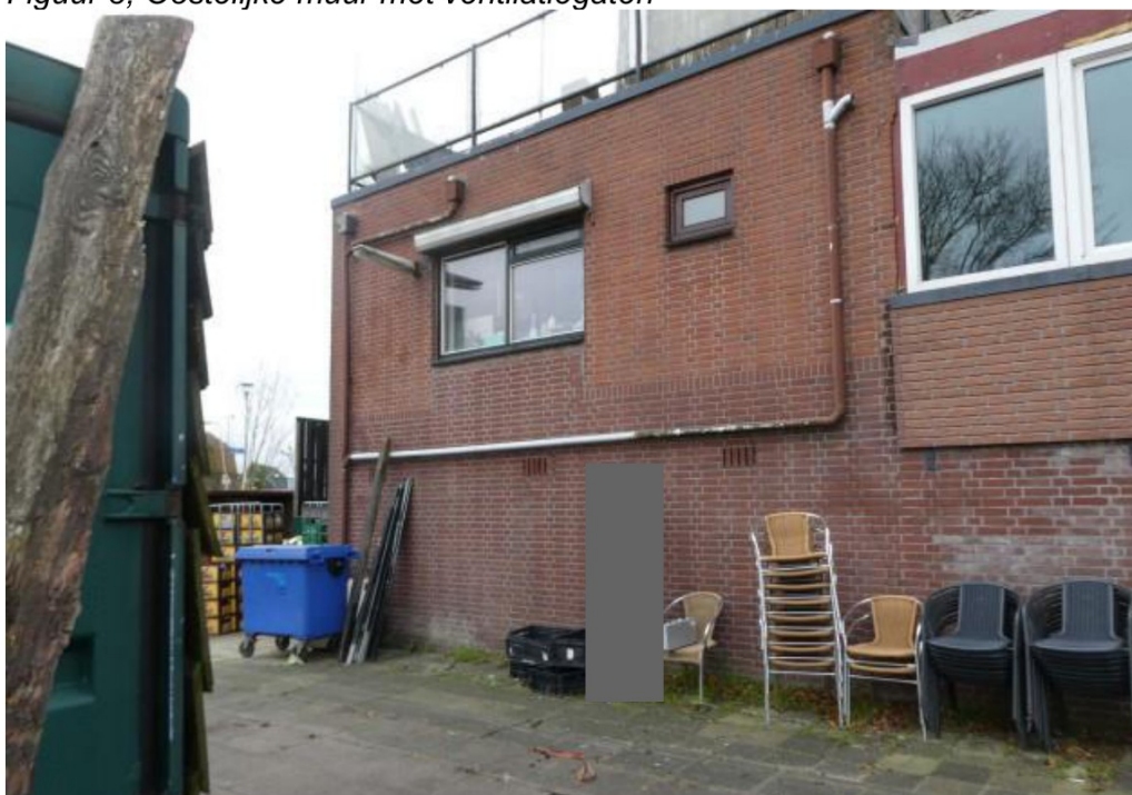
Figuur 3, Oostelijke muur met ventilatiegaten
