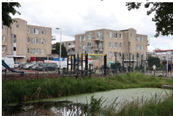
Appartementen aan Hoefslag en Wetering.
