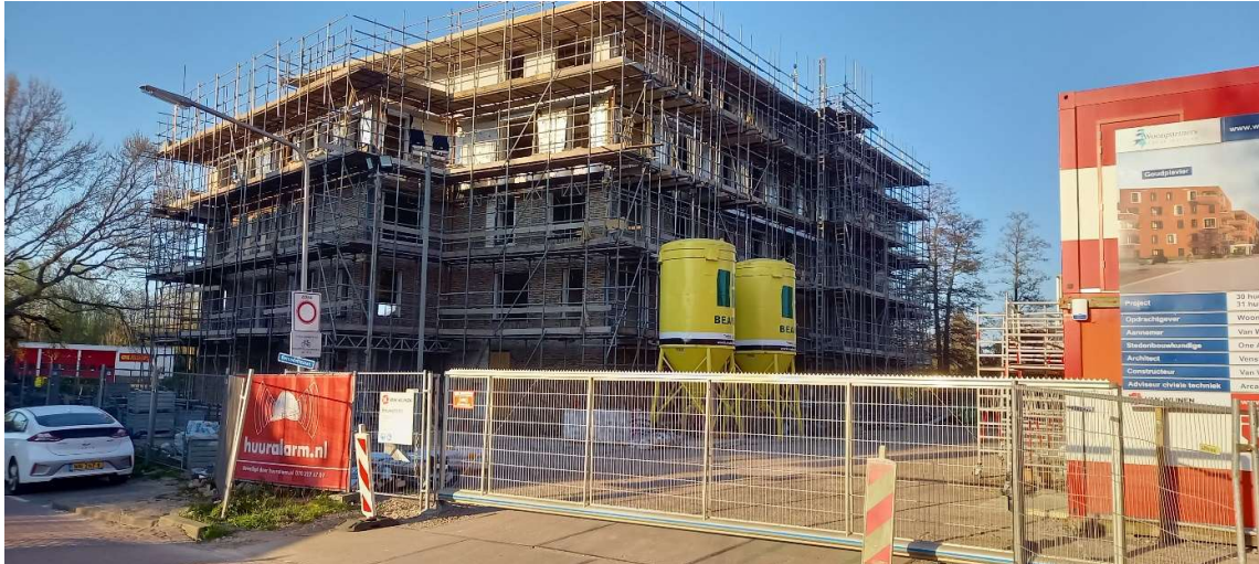
Figuur 3.1: Bouw appartementencomplex: een bodemgevoelig en dus ook een grondwatergevoelig gebouw
