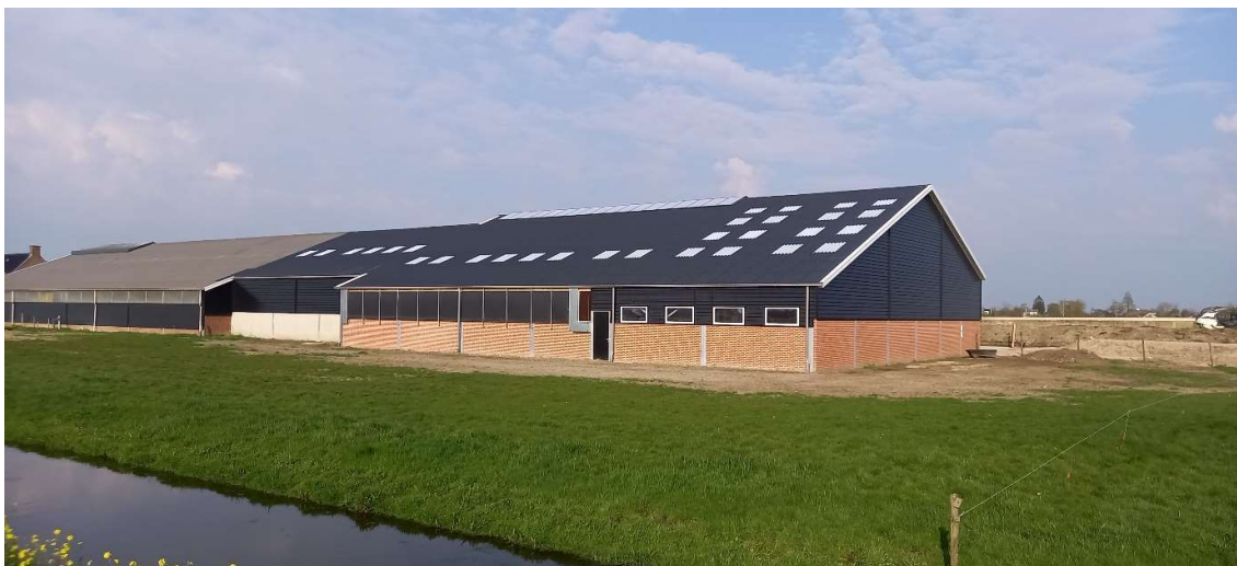
Figuur 3.3: Schuur, meer dan 50 m 2 : geen bodemgevoelig gebouw, maar wel een grondwatergevoelig gebouw
